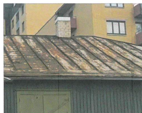
Skarda pažeista korozijos
