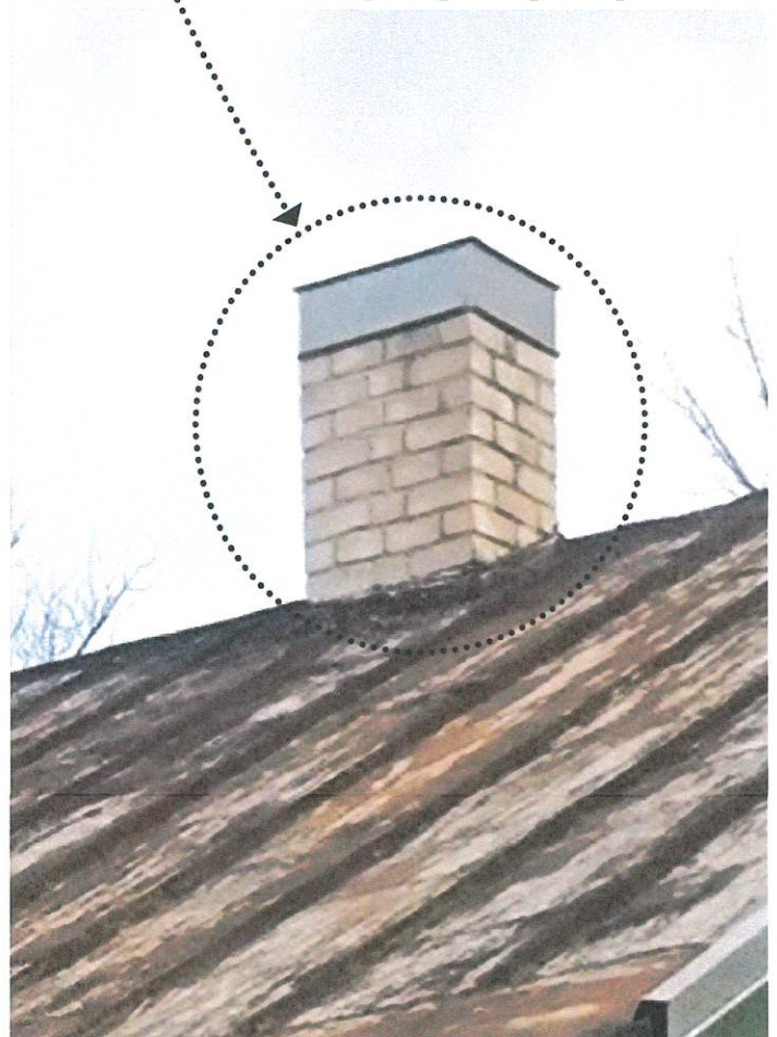
Kaminas permūrytas silikatinėmis plytomis
