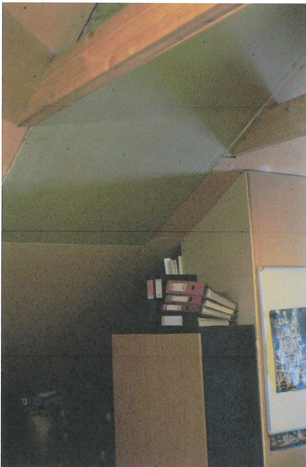
Stogo apačia apdailinta skirtingomis gipso plokštėmis (“žalias” ir “rudas” gipsas)
