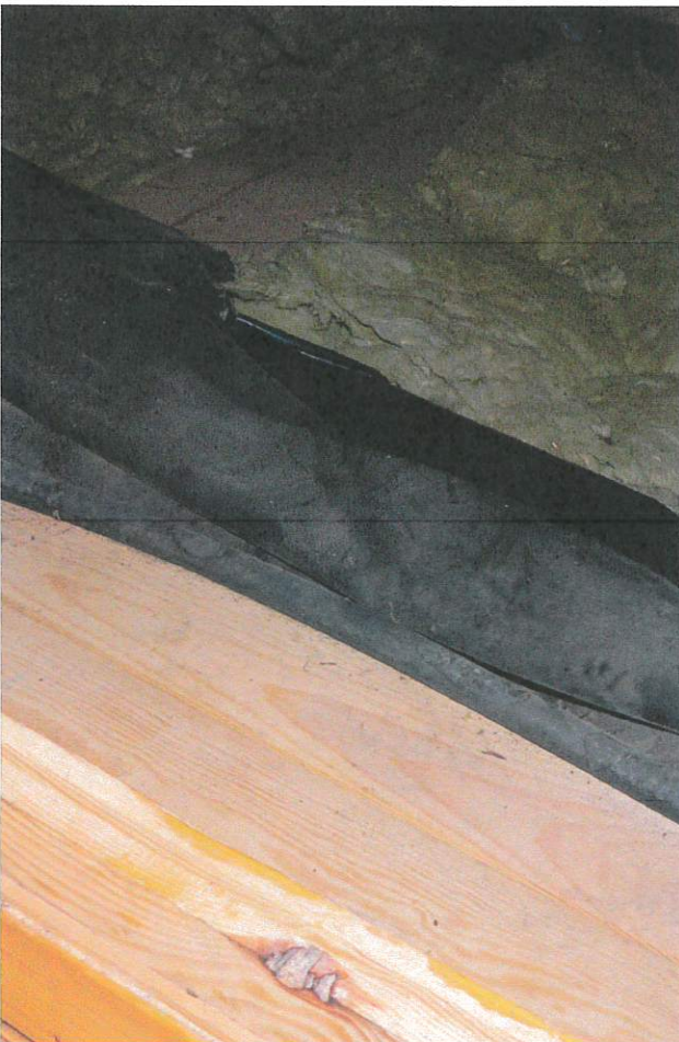
Vaizdas į perdangą tarp 1 aukšto ir pastogės pro dureles patalpoje Nr. 1-12
